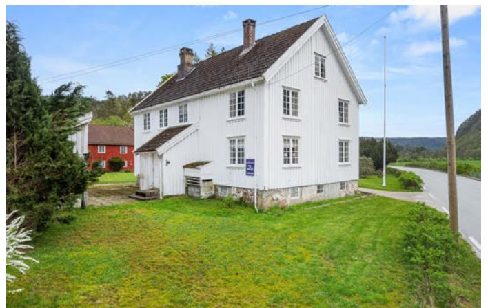
Boligen har normal standard ut ifra alder/konstruksjon, og er jevnlig vedlikeholdt.
