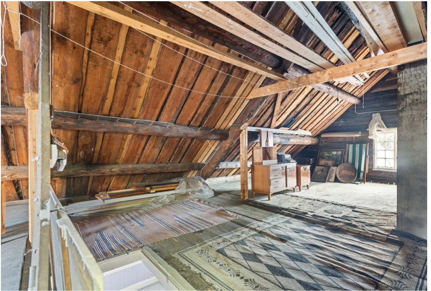
Råloft i huset.
