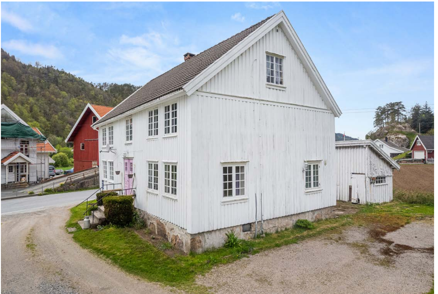
Boligen har normal standard ut ifra alder/konstruksjon, og er jevnlig vedlikeholdt.
