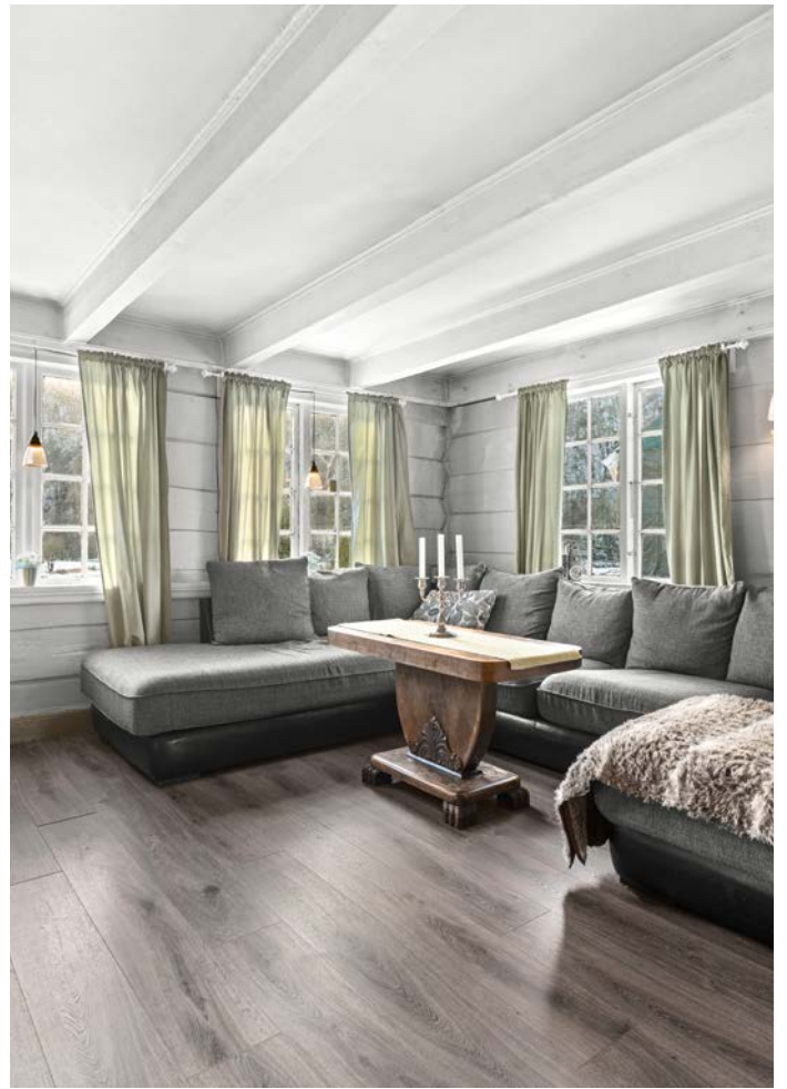
Stuene i første etasje har tømmervegger og himling med malt panel.
