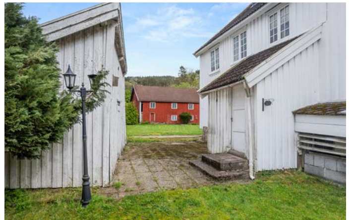
Bod (antatt byggeår 1850) Bygget har gjennomgående lav standard.
