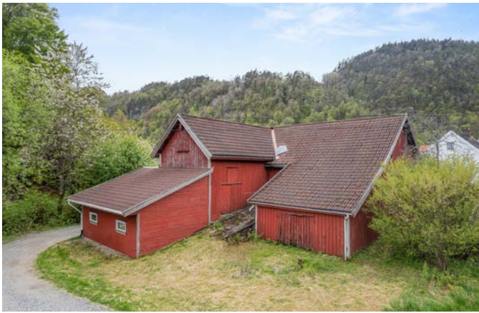
Uthus/låve inneholder: Bod, garasje/carport, 2 lagerrom og verksted.
