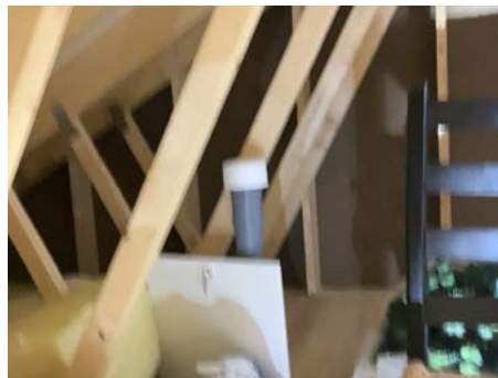
Durgoventil for lufting av avløpsrør.
