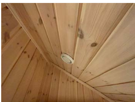
Montert avtrekk i tak.
