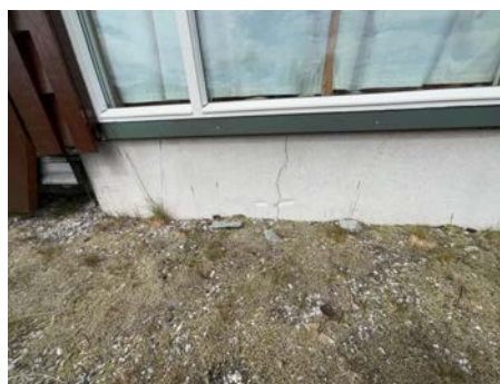
Del av grunnmur.
