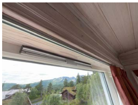
Eksempel på montert ventil i vindu.
