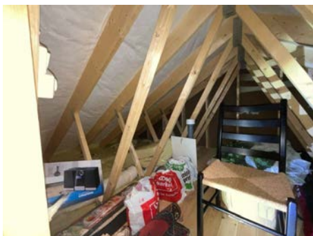
Del av takkonstruksjon, sett fra loft.
