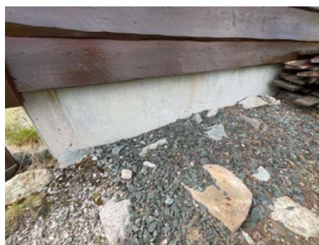
Del av grunnmur.
