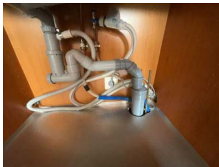
Del av rør til vann.
