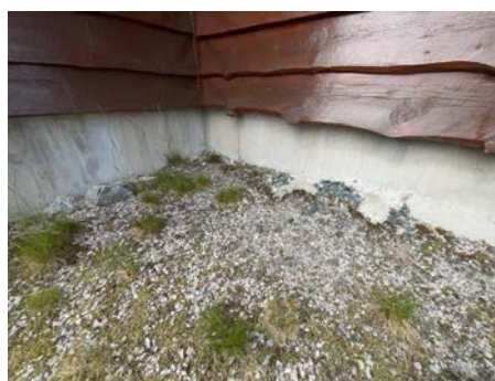
Del av grunnmur.
