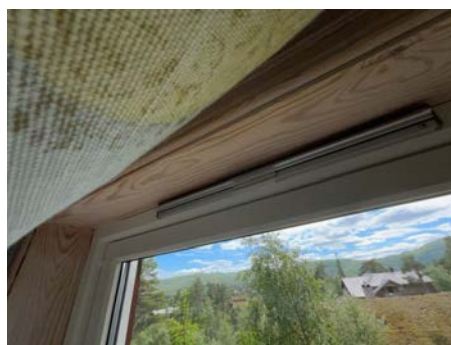
Eksempel på montert ventil i vindu.
