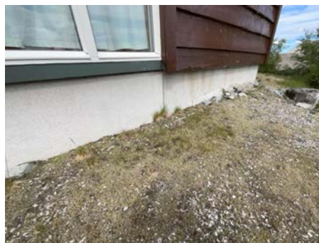
Del av grunnmur.
