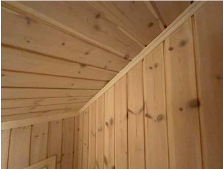
Del av vegg - tak.
