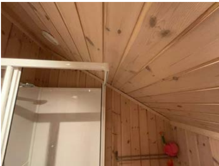
Del av vegg - tak.
