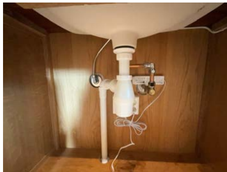
Del av rør til vann.
