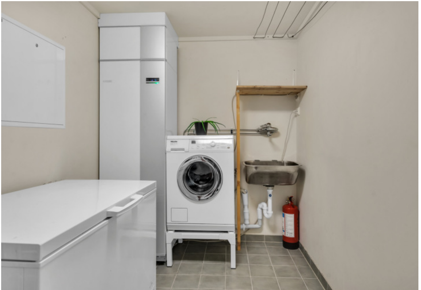
Vaskerom/bod med flislagt gulv og utslagsvask. Opplegg for vaskemaskin.
