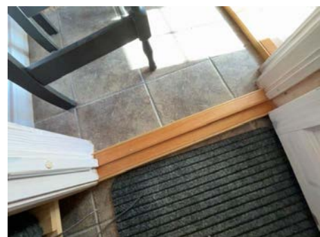
UNDERETASJE > TEKNISK BOD/VASKEROM
