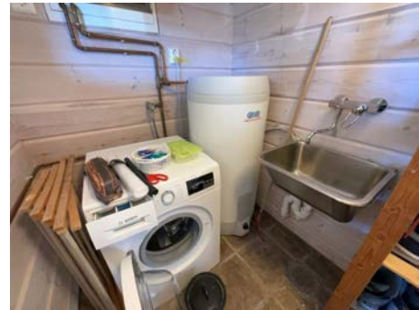
UNDERETASJE > TEKNISK BOD/VASKEROM
