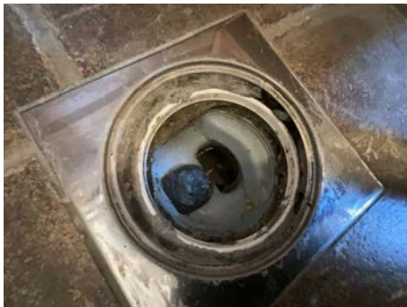
UNDERETASJE > TEKNISK BOD/VASKEROM
