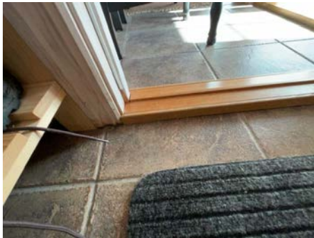
UNDERETASJE > TEKNISK BOD/VASKEROM
