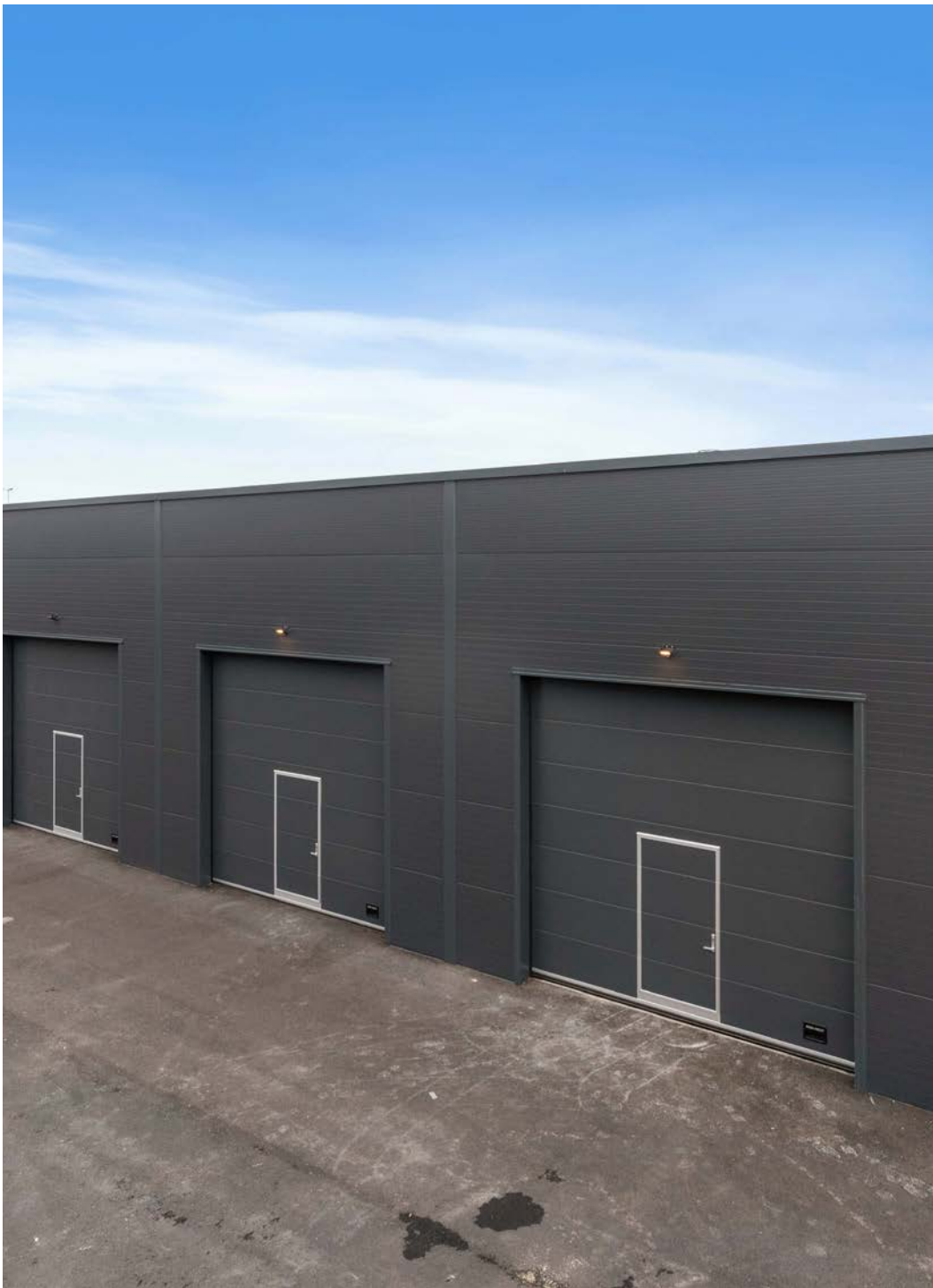
Lagerseksjoner med porter på 4*4 meter, dør i port. Utvendig belysning
