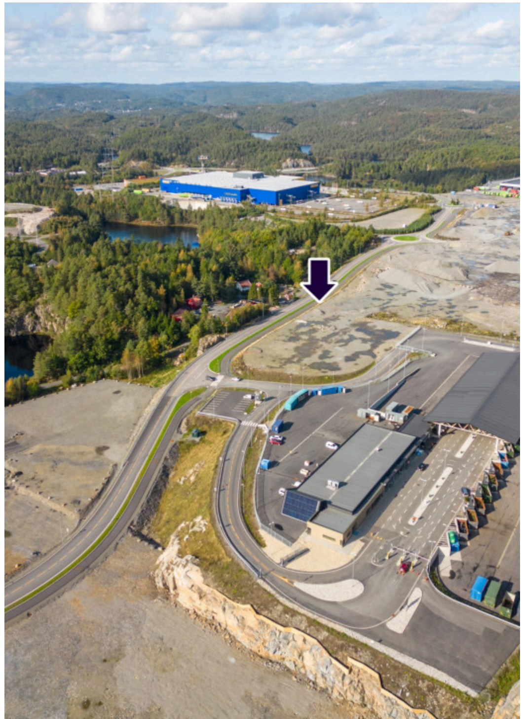
Tomten ligger i nærheten av ny avfallstasjon for Kristiansand Øst.
