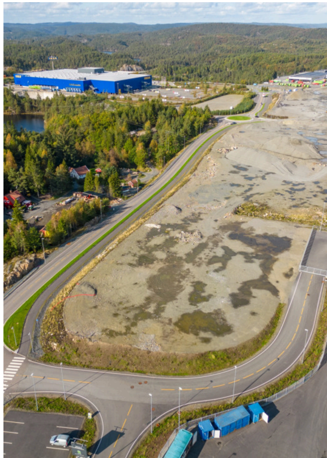
Flat opparbeidet tomt med infrastruktur og mulighet for enkle installasjoner
