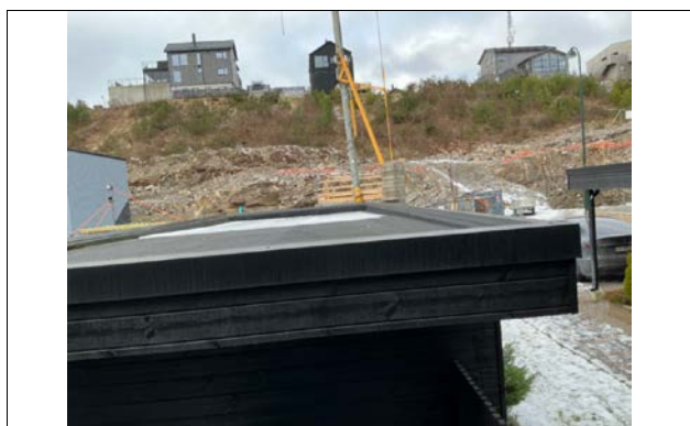
Beslag montert i overgang mot takteking
