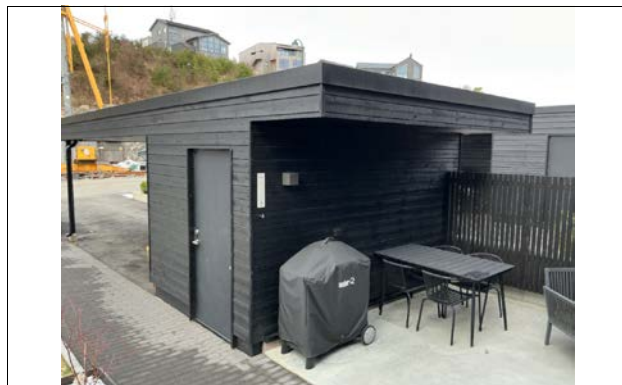
Carport med bodbygg i bakkant
