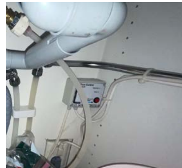
Vannstoppersystem i kjøkkenbenk.
