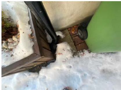
Nedløp tilkoblet rør ved grunn.
