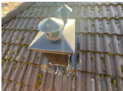
Beslag rundt Luftelyre.
