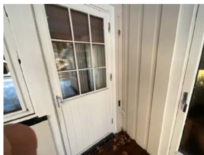
Balkondør i stue i første etasje er ok.
