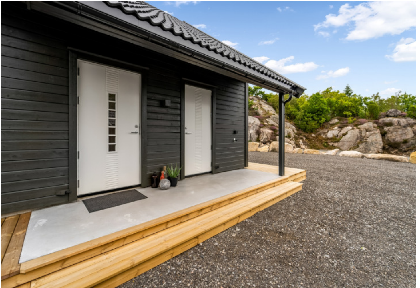
2-delt inngangsparti - hovedinngang og inngang via vaskerom.
