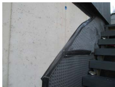
Synlig fuksikring inntil grunnmur
