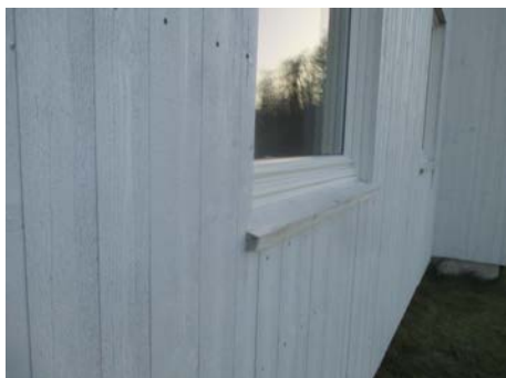
Deler av kledningen med tilhørende belistninger.
