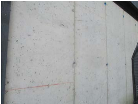
Deler av støpt grunnmur.
