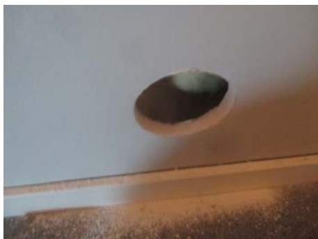
Hulltaking i utfored vegg på kjøkkenet til utleiedelen.
