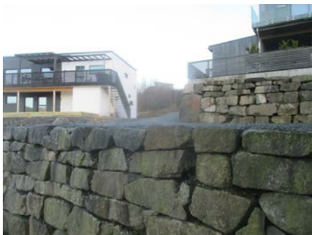
Forstøtningsmur i mot parkeringsplass.
