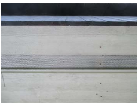
Luftespalter i gesimsen.
