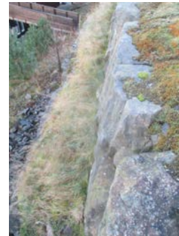
Deler av forstøtningsmur foran boligen.
