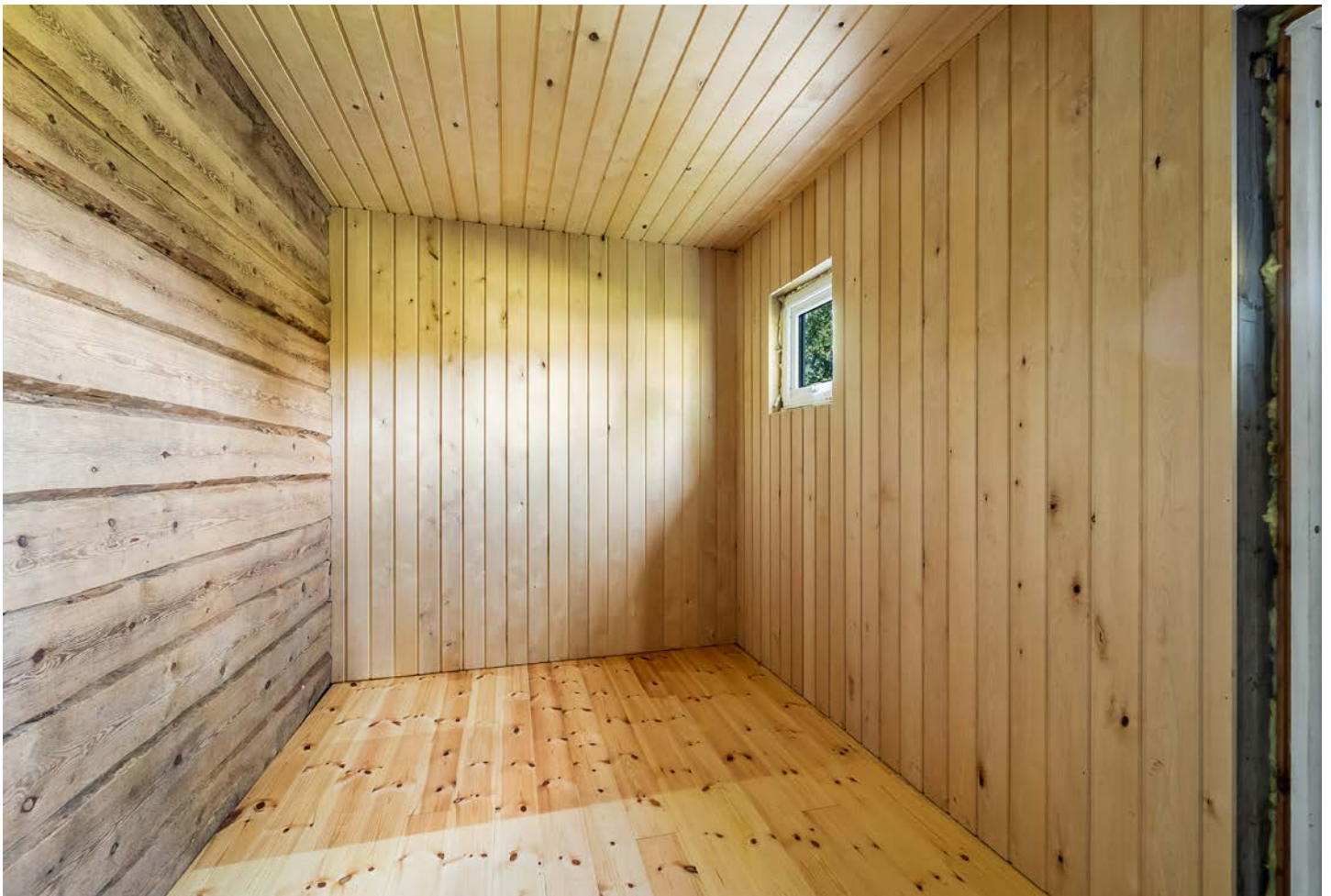
Bislaget har original stokkevegg, nytt gulv og ny panel på gulv og vegger.
