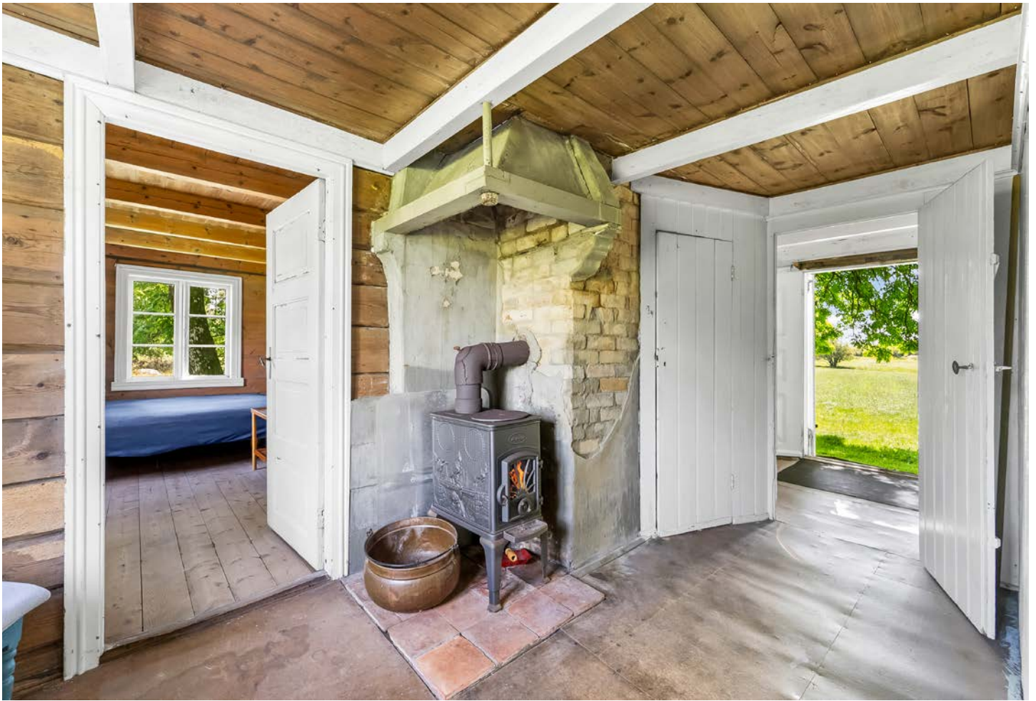
Kjøkkenet er ribbet for å bygges opp på nytt. Nyere vedovn er installert og er i bruk.
