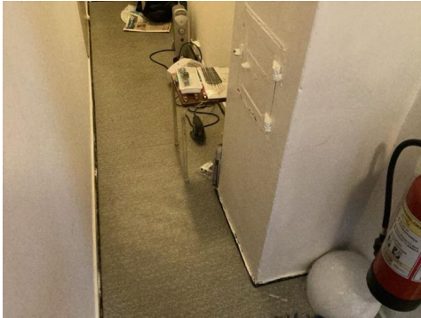
Ildfast plate på gulv bør monteres
