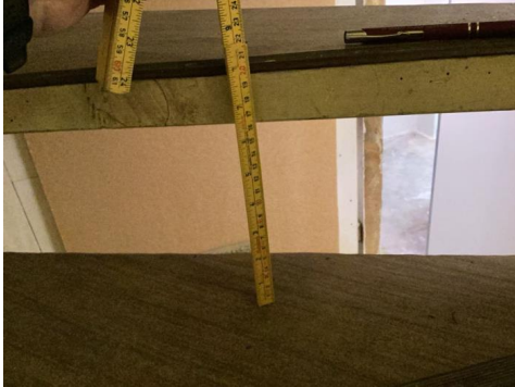
Åpninger er større enn dagens krav
