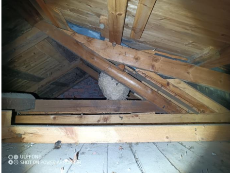
Takkonstruksjon besiktet fra luke
