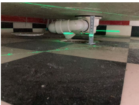
Måling ved sluk
