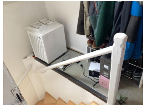
Det bør monteres rekkverk
