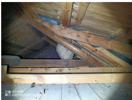
Takkonstruksjon besiktet fra luke
