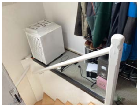
Det bør monteres rekkverk
