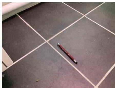
Bom under flis, sprekk i fug
