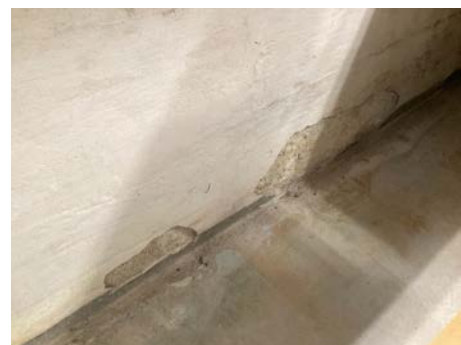
Avflassing av puss
