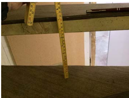
Åpninger er større enn dagnes krav
