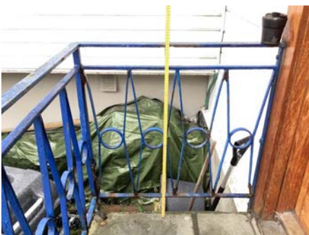
Rekkverk er lavere enn dagens krav. Åpninger i rekkverk er større enn dagens krav.
