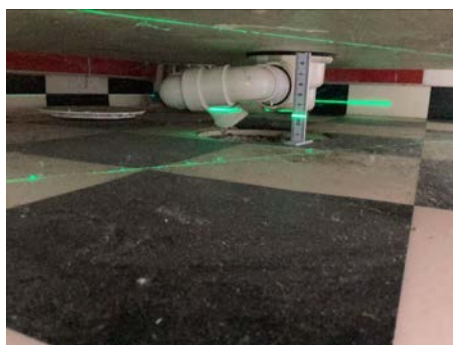
Måling ved sluk
