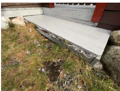
Opptrinn mot terrasse.
