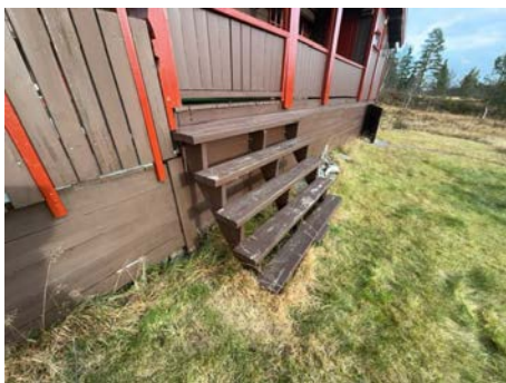
Utvendig trapp i tre.
