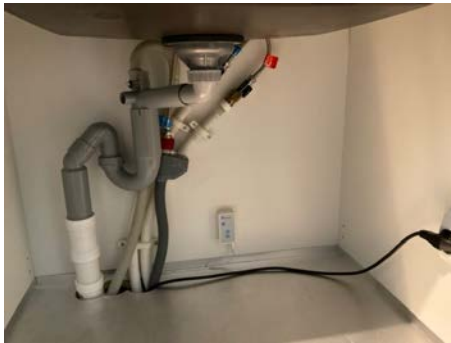
Skap under vask med røropplegg.
