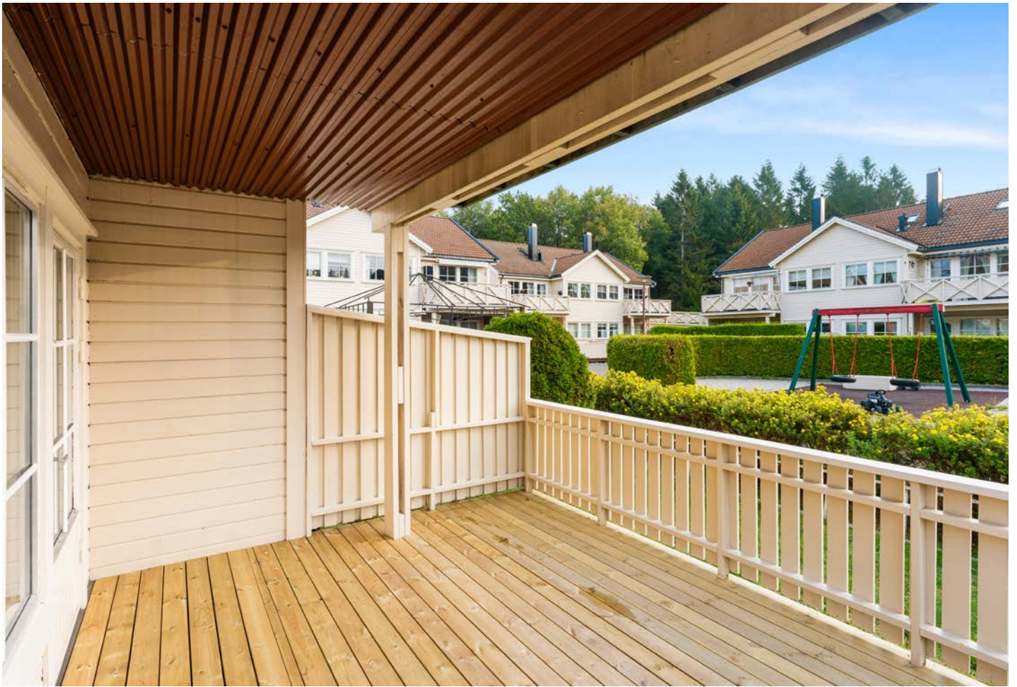
Fra stuen er det direkte utgang til terrassen. Den er nylig oppgradert med nytt dekke.
