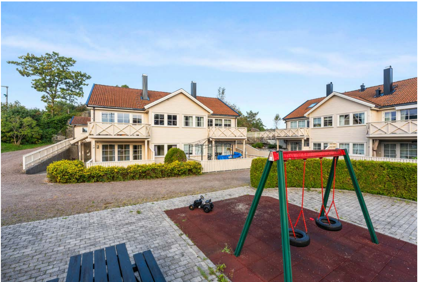
Hyggelig sameie og nærområde. Pent opparbeidet fellesareal med bla lekeplass.
