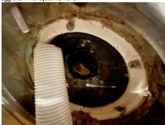
Feilmontert membran til sluk
