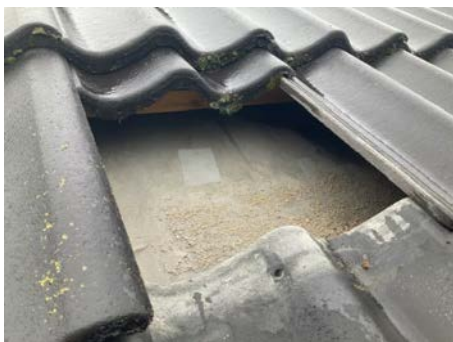
Stikk kontroll undertak. Normal slitasje registrert.
