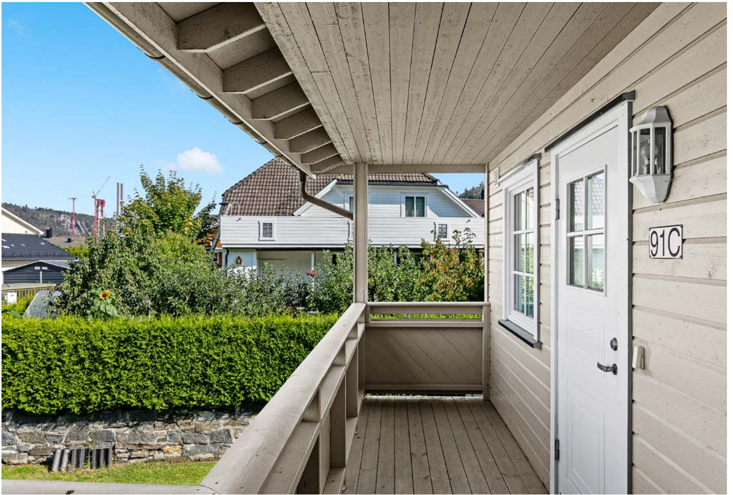
Overbygget liten uteplass ved inngangspartiet
