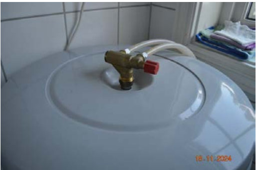
TG 1 Elektrisk anlegg
