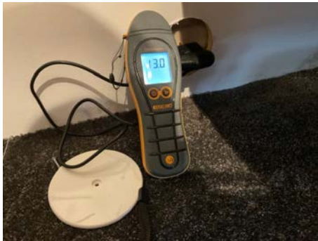
Hull i påforet vegg.
