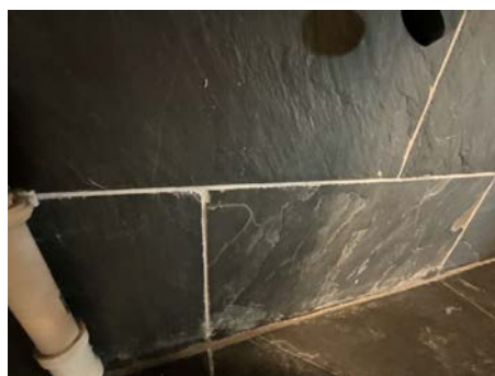
ETASJE 1(UNDERETASJE) > BOD/VASKEROM
