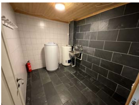
ETASJE 1(UNDERETASJE) > BOD/VASKEROM
