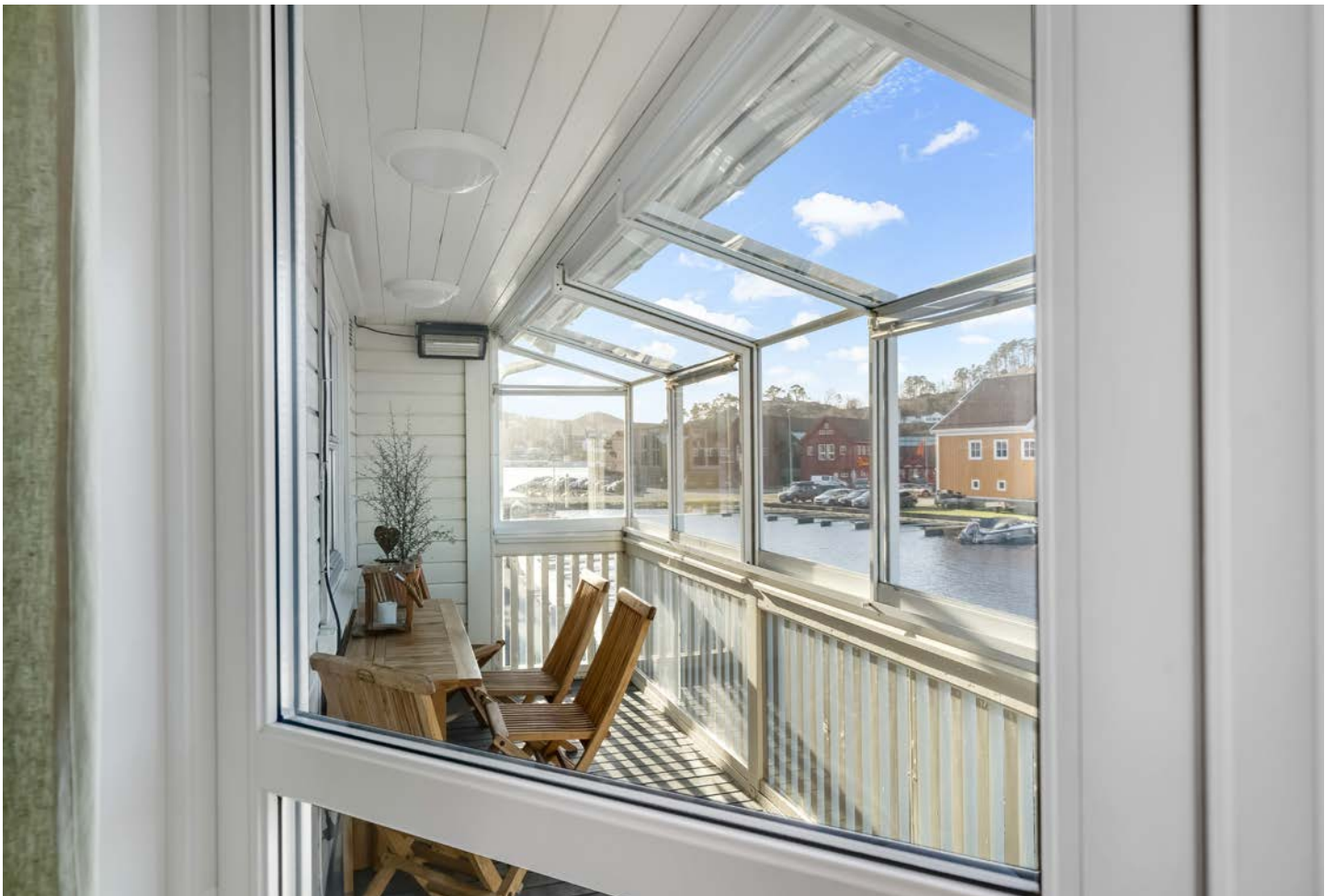
Terrasse som er innebygd med skyvbare glassfelt.
