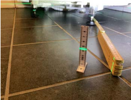
Måling 80 cm fra sluk under kabinett
