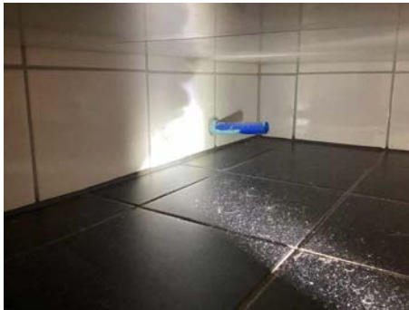
Drensrør fra vannfordelerskap på vaskerom / bad
