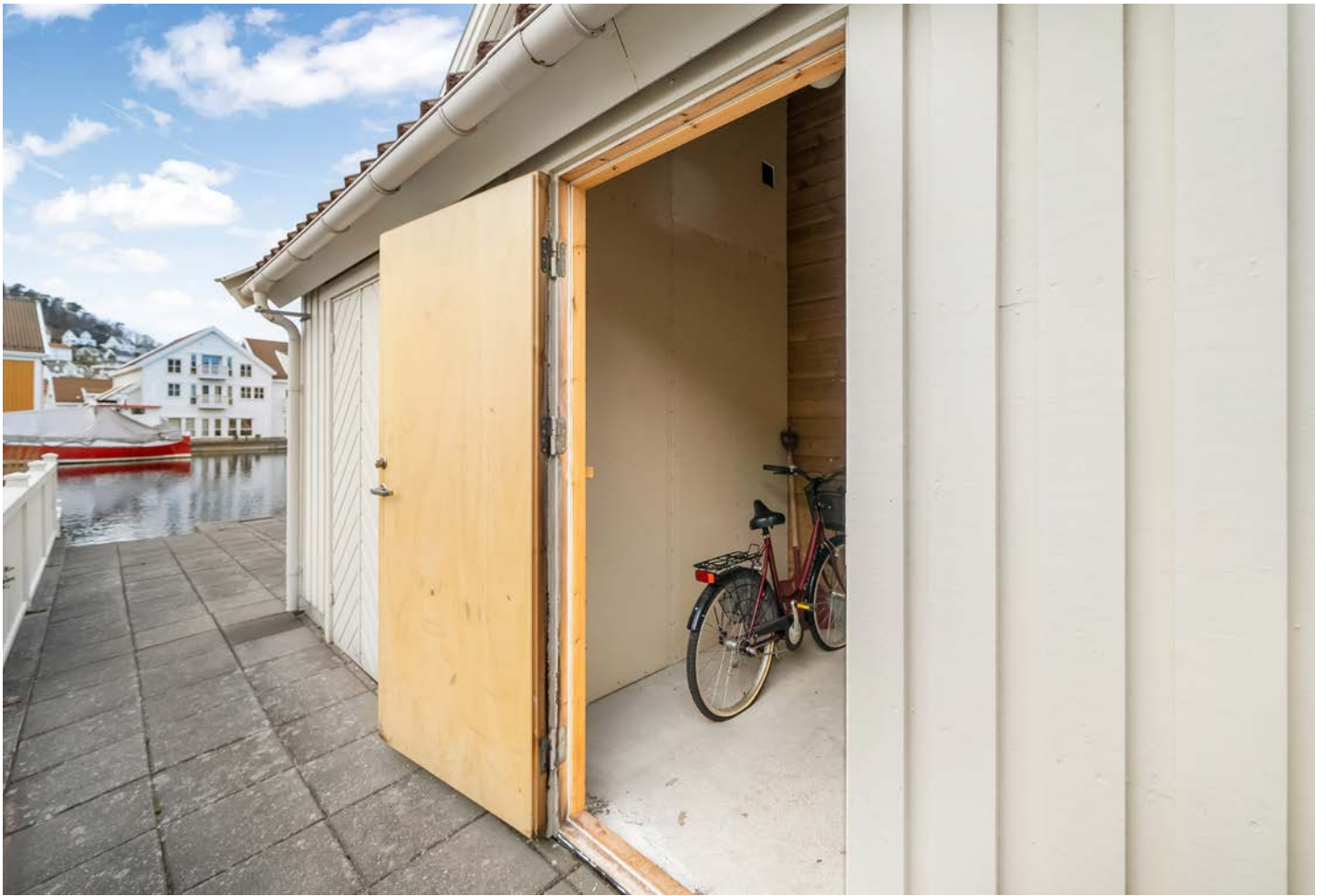
Praktisk utvendig bod for lagring rett på siden av bygget.
