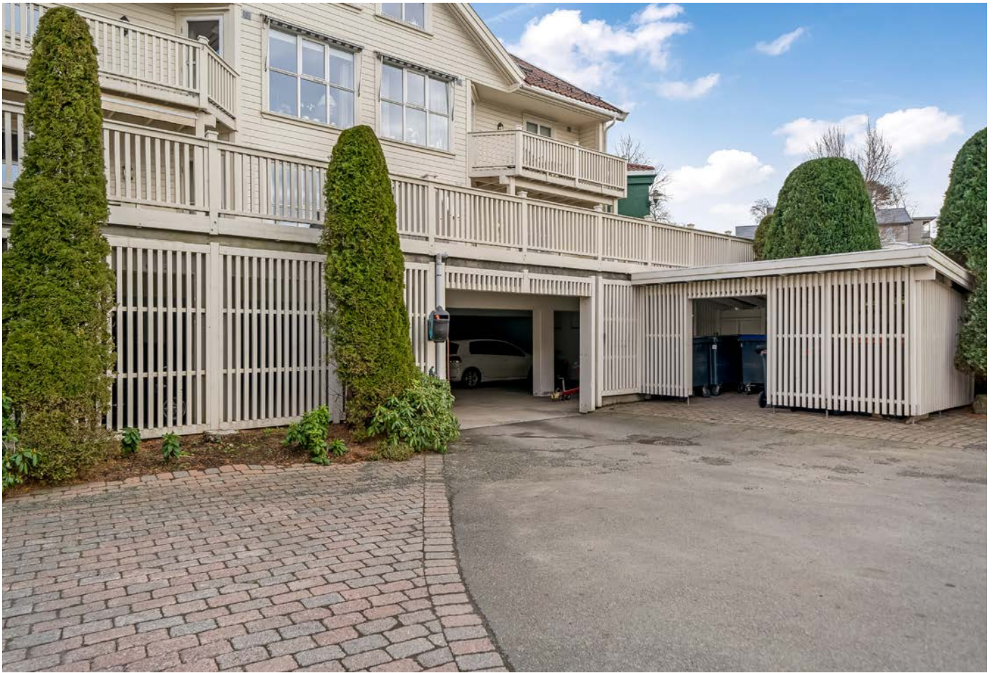
Garasjeplass i felles anlegg.
