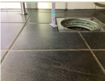
måling ved sluk under innredning
