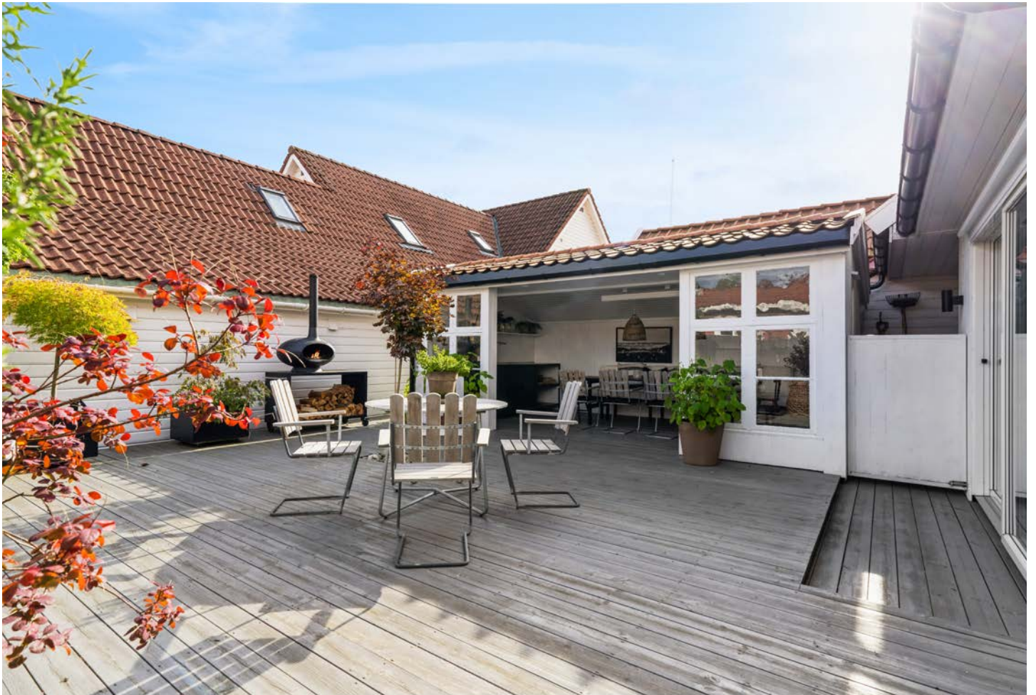
Hagestue er ikke byggesøkt
