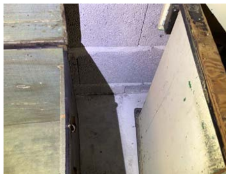
Yttervegg i lettklinker
