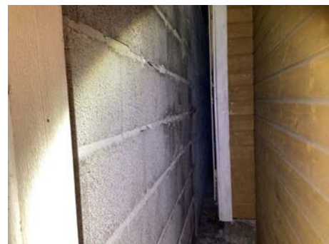
Bakvegg i lettklinker, vegg er ikke pusset.
