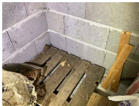
Yttervegg i lettklinker
