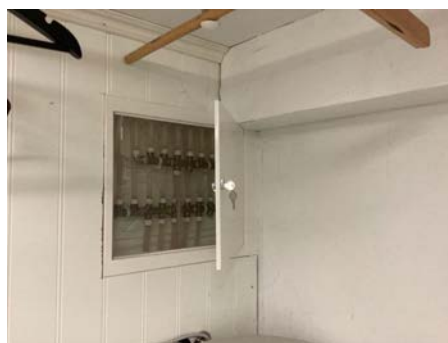
Dør til skap tar i kanal over
