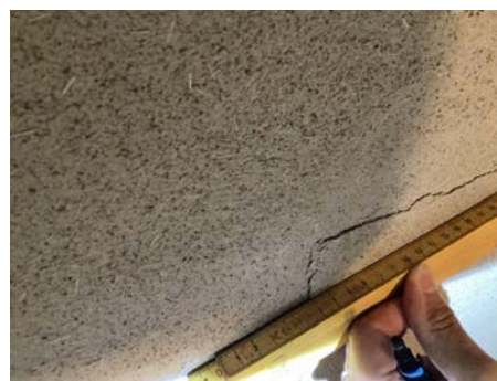
Resultat av jordtrykk på grunnmur
