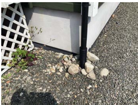
Synlig grunnmursplast rundt bygg
