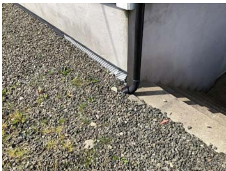
Taknedløp til drenering i grunn
