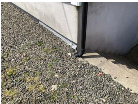
Taknedløp til drenering i grunn
