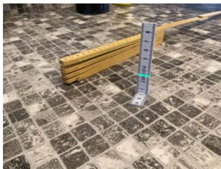
Måling 80 cm fra sluk
