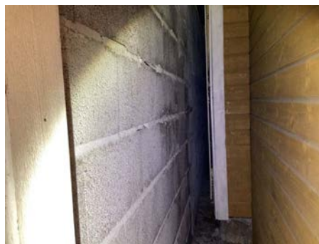
Bakvegg i lettklinker, vegg er ikke pusset.
