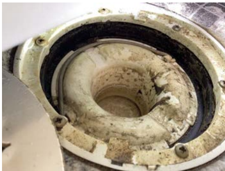
Sluk ved badekar med klemt belegg under klemring
