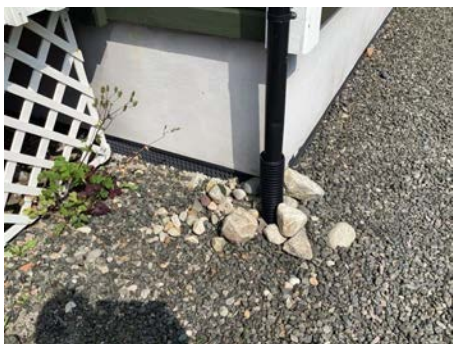
Synlig grunnmursplast rundt bygg
