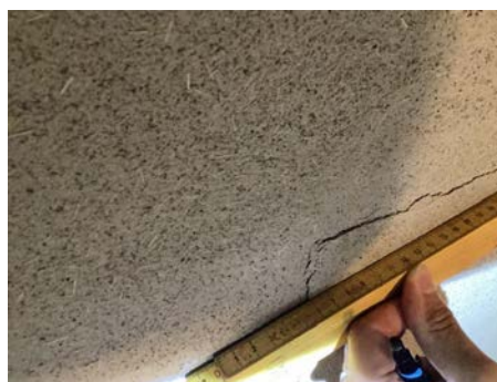
Resultat av jordtrykk på grunnmur
