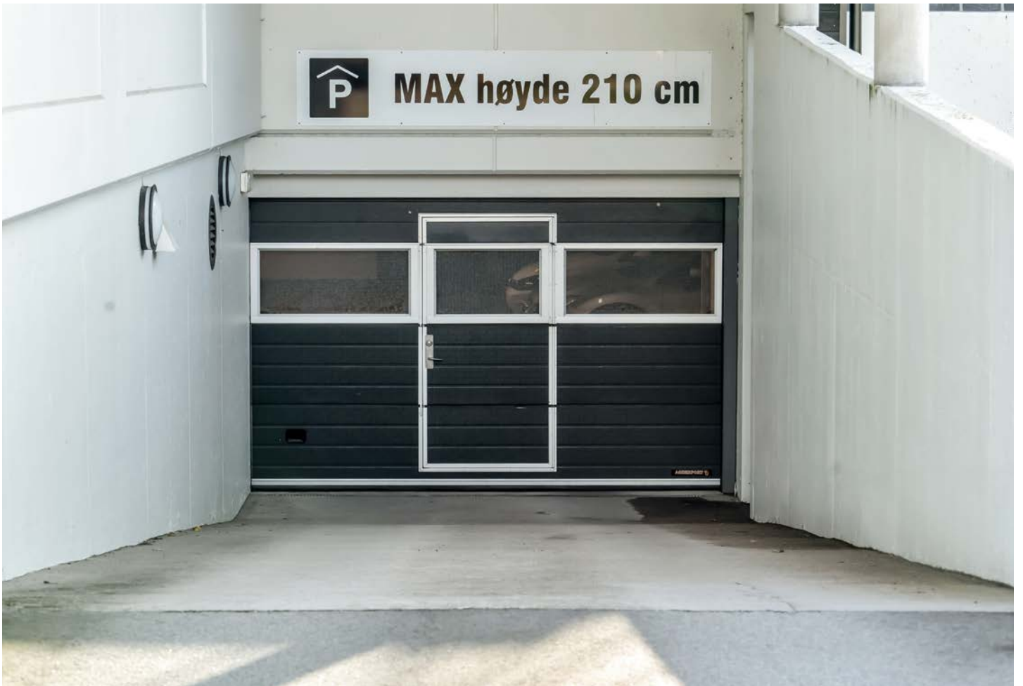
Innkjøring til garasje - garasjeanlegg med automatisk portåpner.
