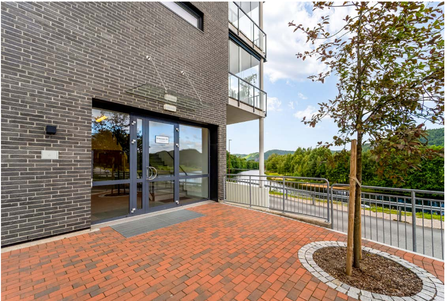
Inngang til bygget med callinganlegg med adgangskontroll. Heis i bygget.
