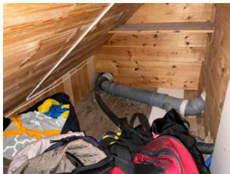
Avløpsrør på loft.
