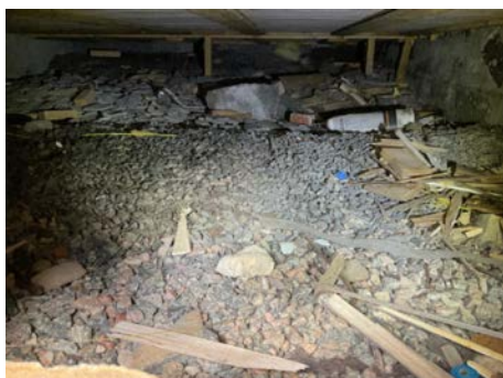
Krypkjeller under tilbygg fra 2008
