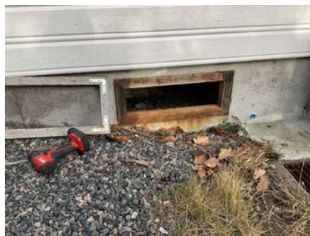
Luke inn til krypkjeller under tilbygg.
