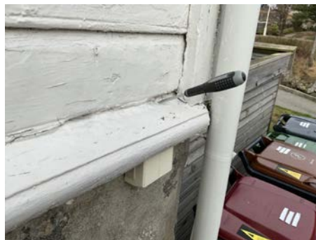
Råteskade i kledning.
