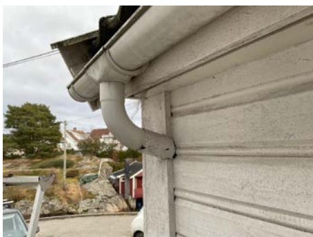
Taknedløp føres inn bak kledning.
