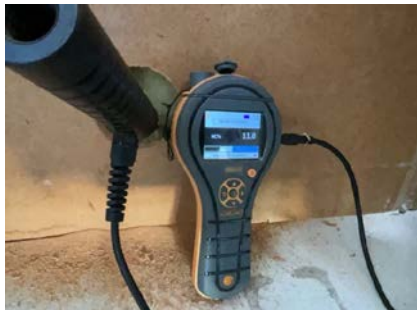
Hulltaking - Fuktmåling - Tørr konstruksjon i hulltakingsområdet.
