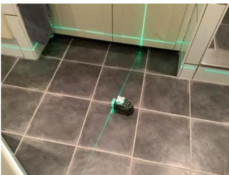
Kontroll av fallforhold til hovedsluk.
