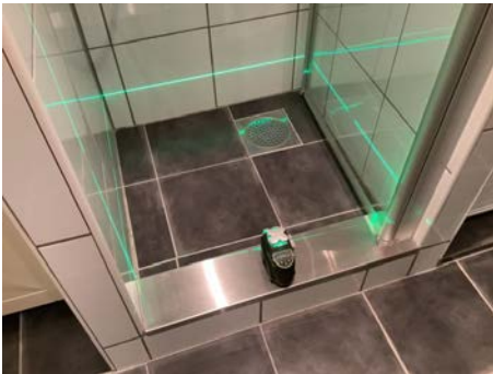
Kontroll av fallforhold i dusjhjørnet.
