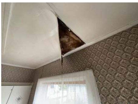
Bilde viser skade i innvendig takhimling på kjøkken.
