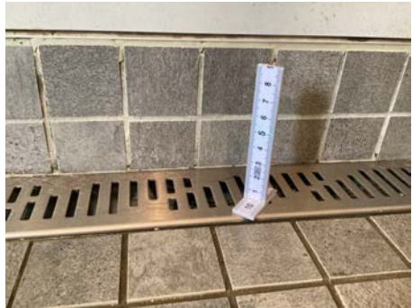
Måling ved sluk
