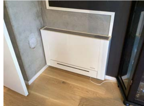
Innvendig varmepumpe
