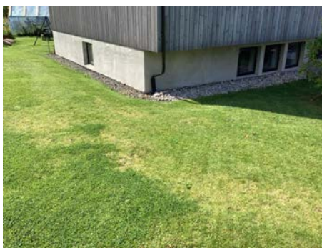
Drenerende masser langs grunnmurplast
