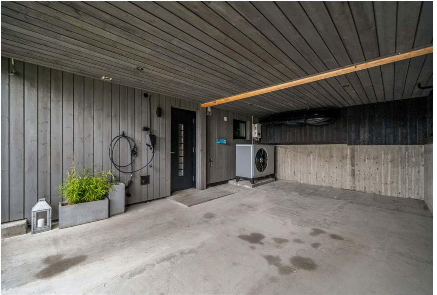
Carport med adkomst inn til boligen, samt el-billader.
