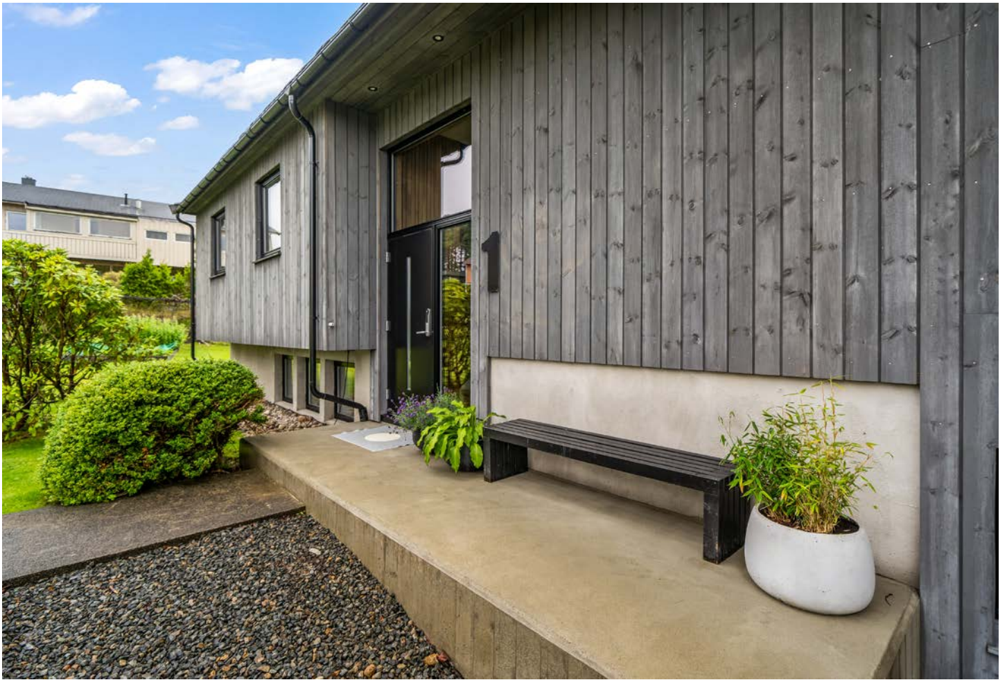
Overbygd inngangsparti med støpt plattform.
