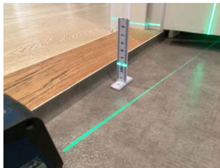
Måling ved terskel
