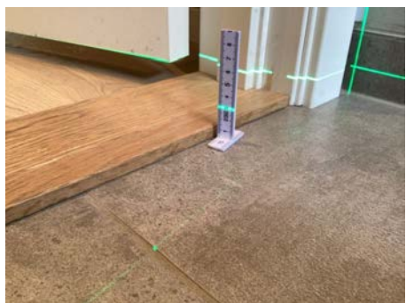
Måling ved terskel
