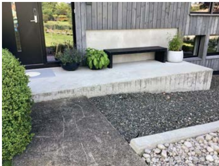
Høyde ned til terreng er over 50 cm, og det vil være krav til rekkverk på en side
