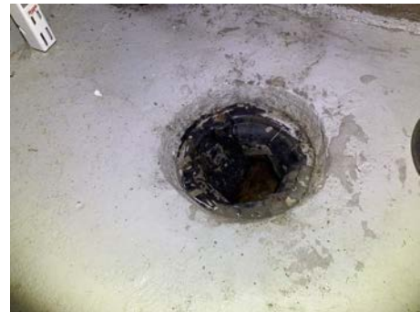
Eldre sluk, gulv har ikke tettesjikt
