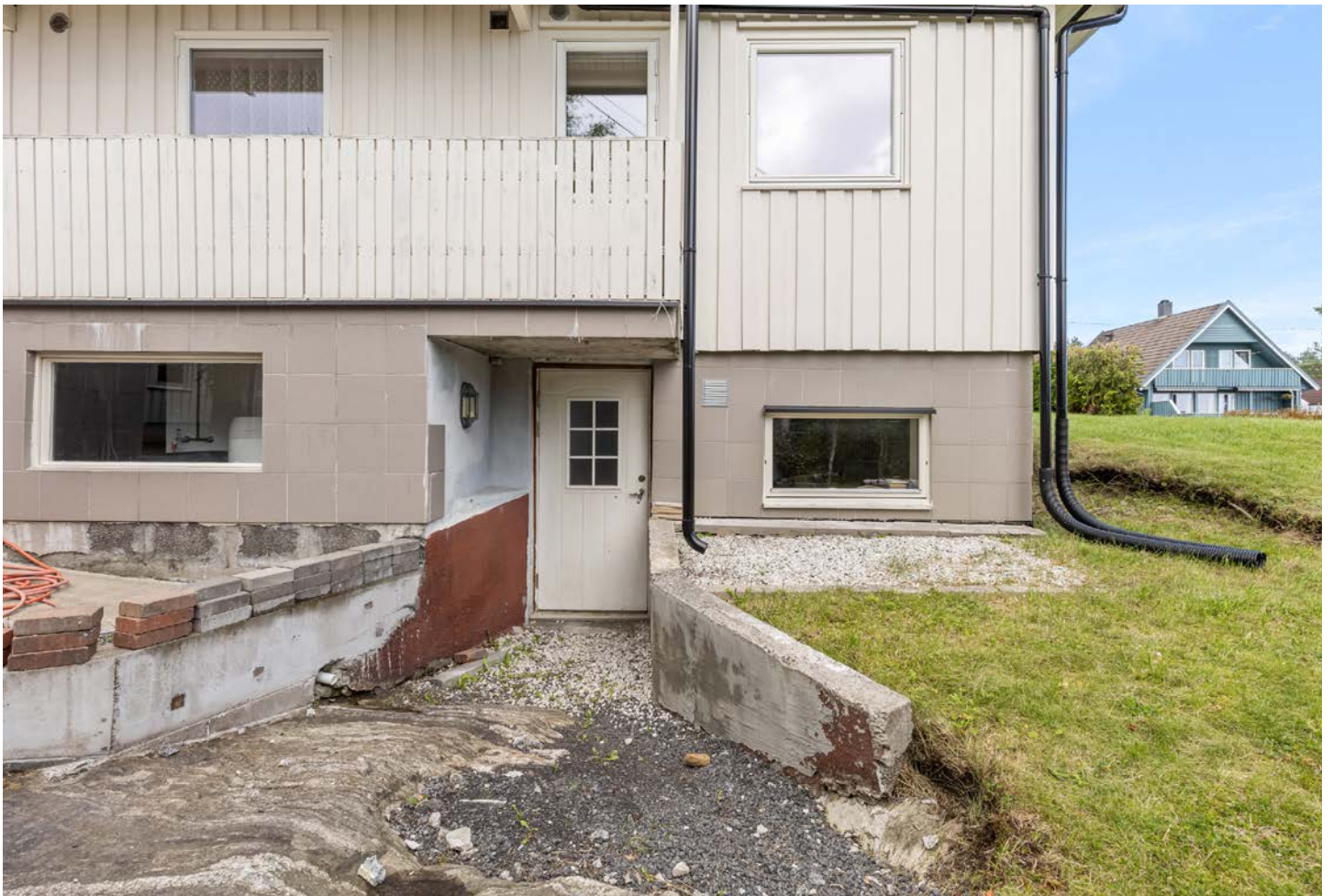
Inngang til kjeller
