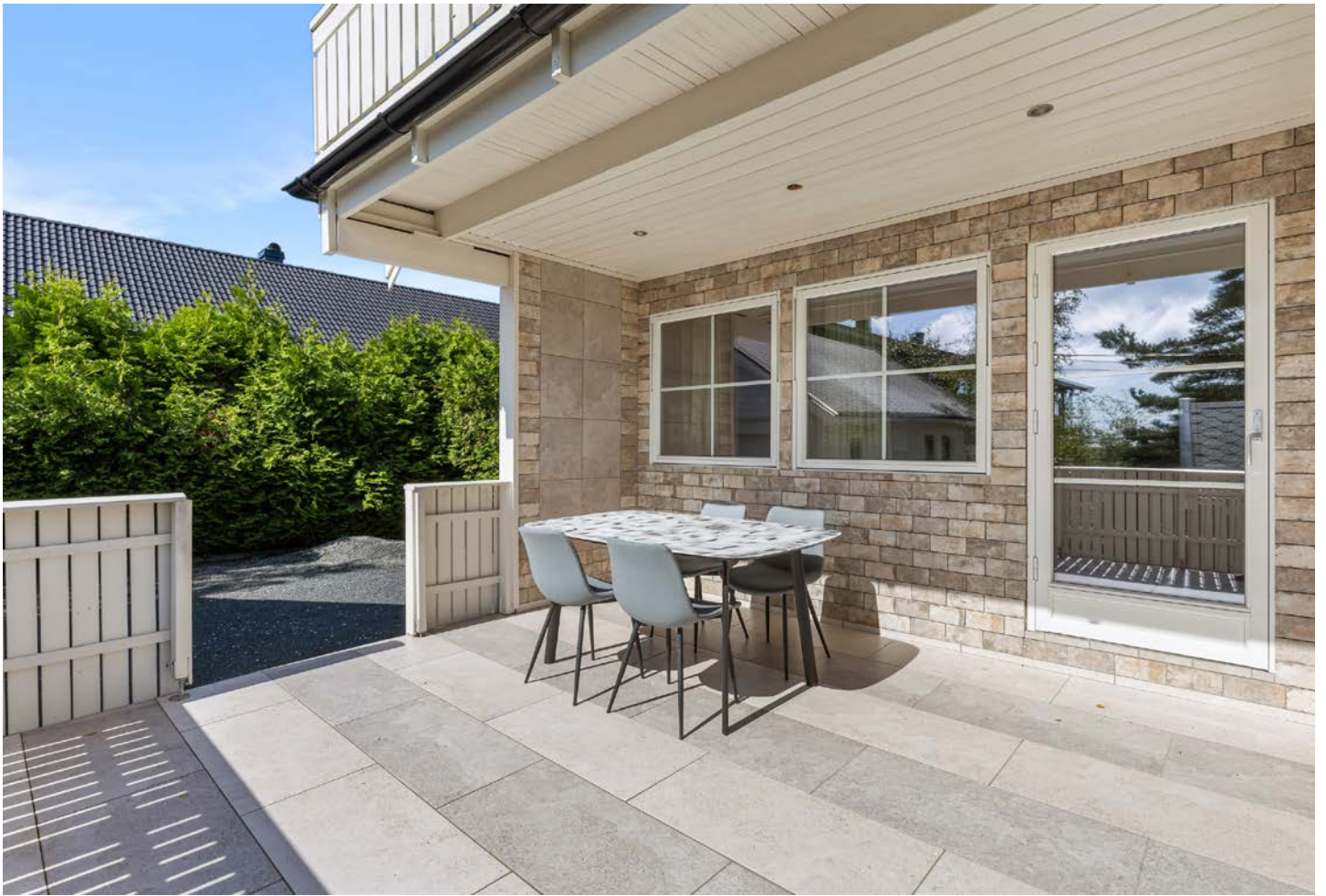
Flislagt terrasse med delvis overbygd tak
