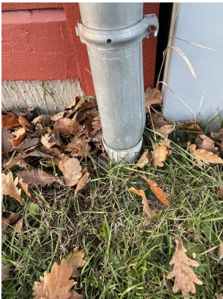
Takvann er ført ned i dør i terrenget.
