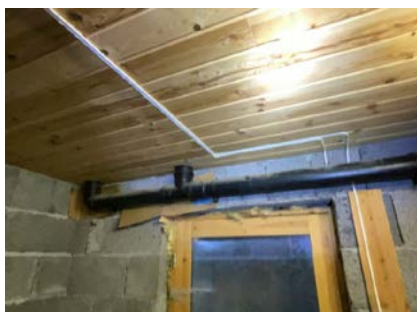
Avbrutt kloakklufting på kryploft.
