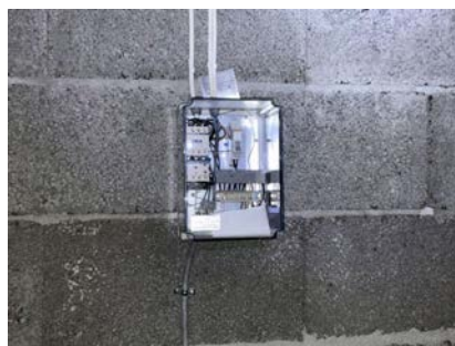
Styrestrøm - Privat avløpspumpe.
