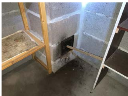
Sotlukedør uten tilstrekkelig lukkemekanisme.
