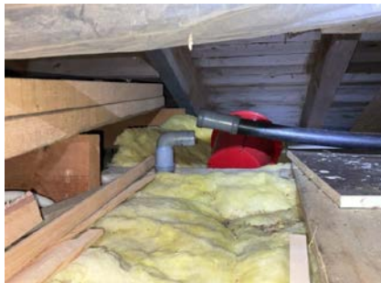
Avbrutt kloakklufting på kryploft.
