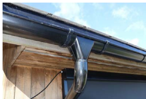
Takrenner og nedløp fra 2017.
