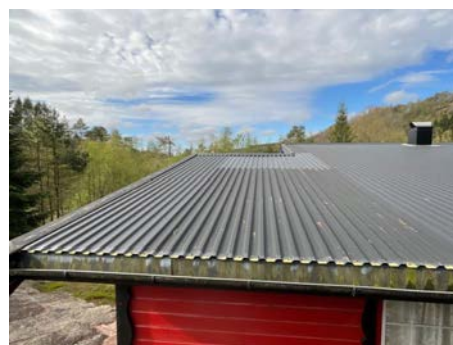
Fukt- og råteskader i vindski/vannbord
