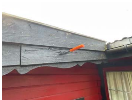
Fukt- og råteskader i vindski/vannbord
