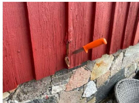
Bordkledning går stedvis ned til terrenget.
