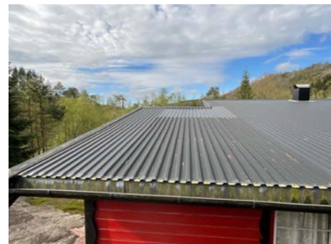
Fukt- og råteskader i vindski/vannbord
