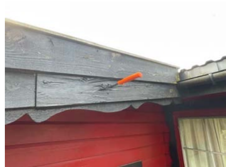
Fukt- og råteskader i vindski/vannbord
