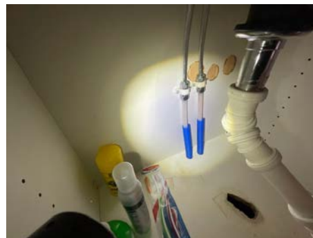
Det mangler tettmuffer under servant på toalettrom.
