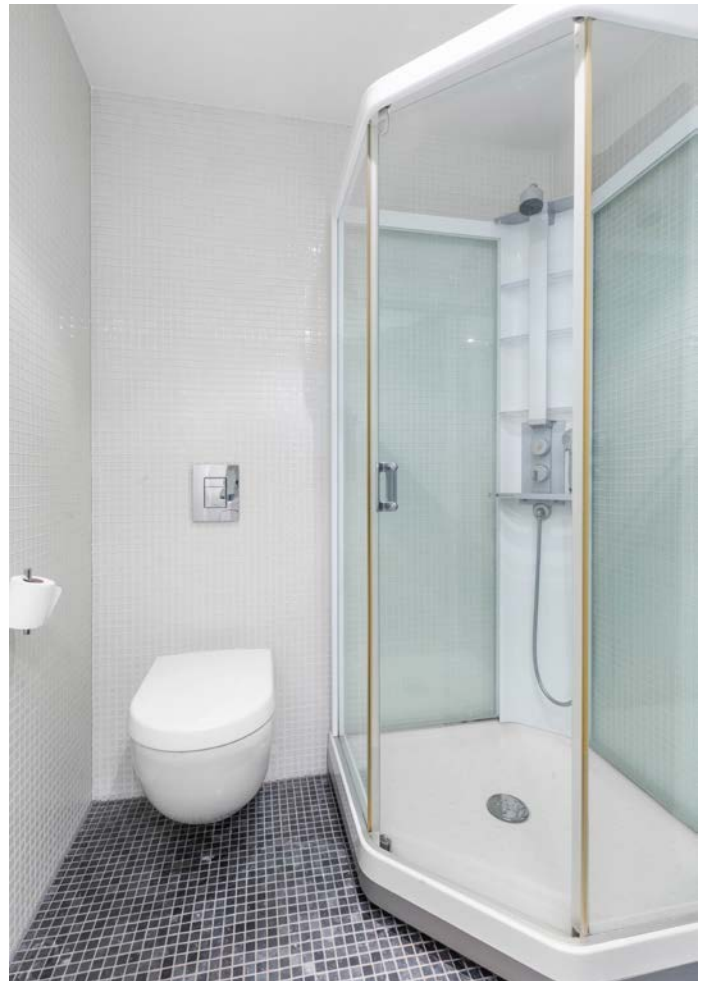
Pent flislagt bad med dusjkabinett, baderomsinnredning og vegghengt toalett.
