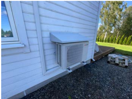
Varmepumpe utvendig aggregat.
