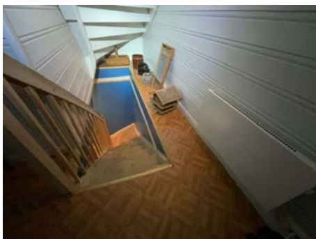
Bilde viser manglende rekkverk i toppen av trappen.
