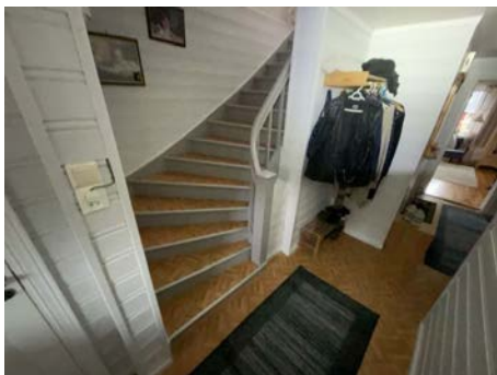
Bilde viser manglende rekkverk i toppen av trappen.
