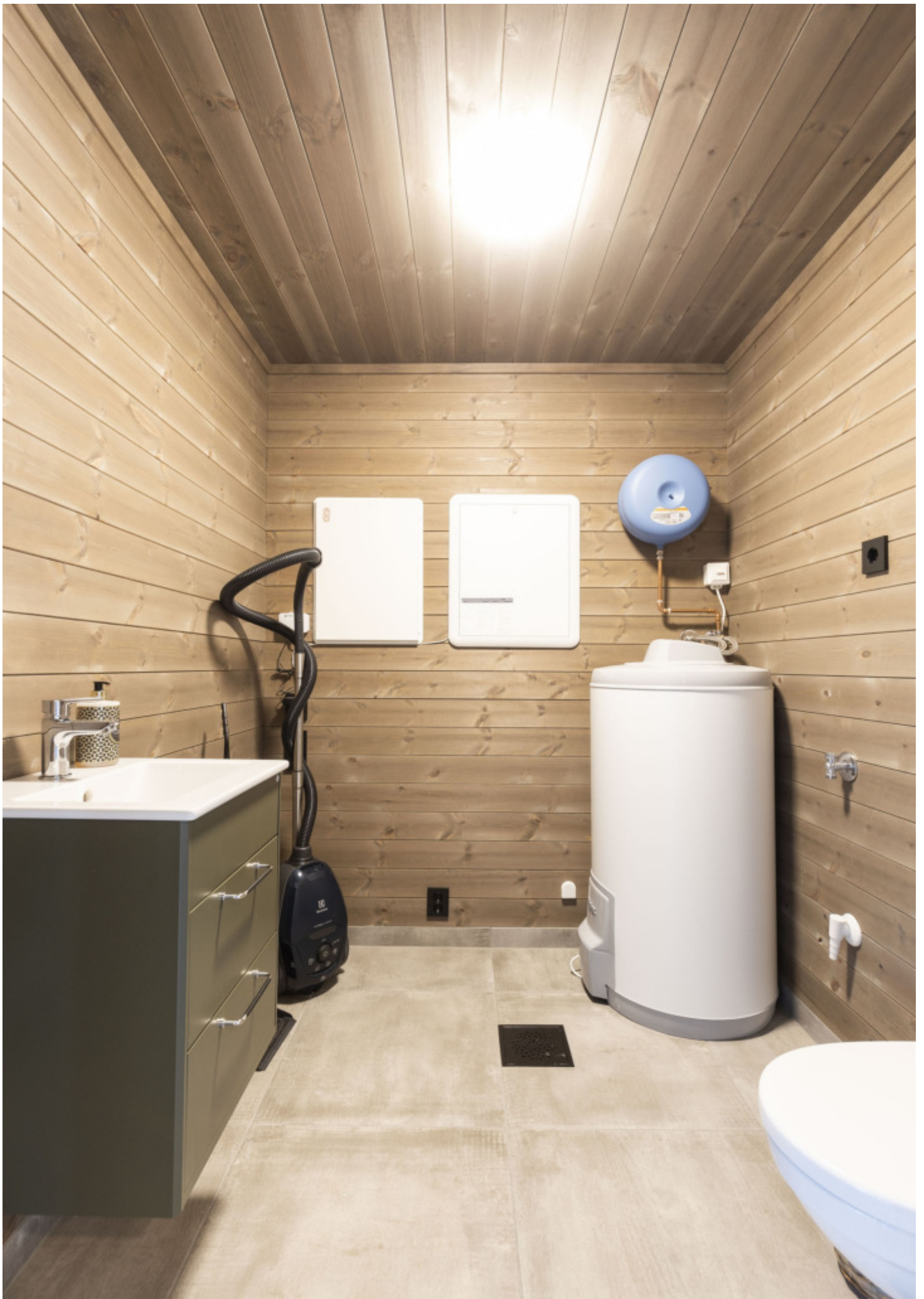
Vaskerom har også ekstra toalett og servant i tillegg til opplegg for vaskemaskin
