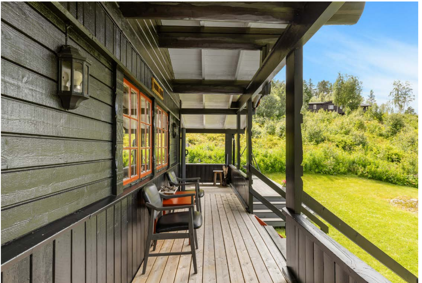
Overbygd tak over deler av terrassen
