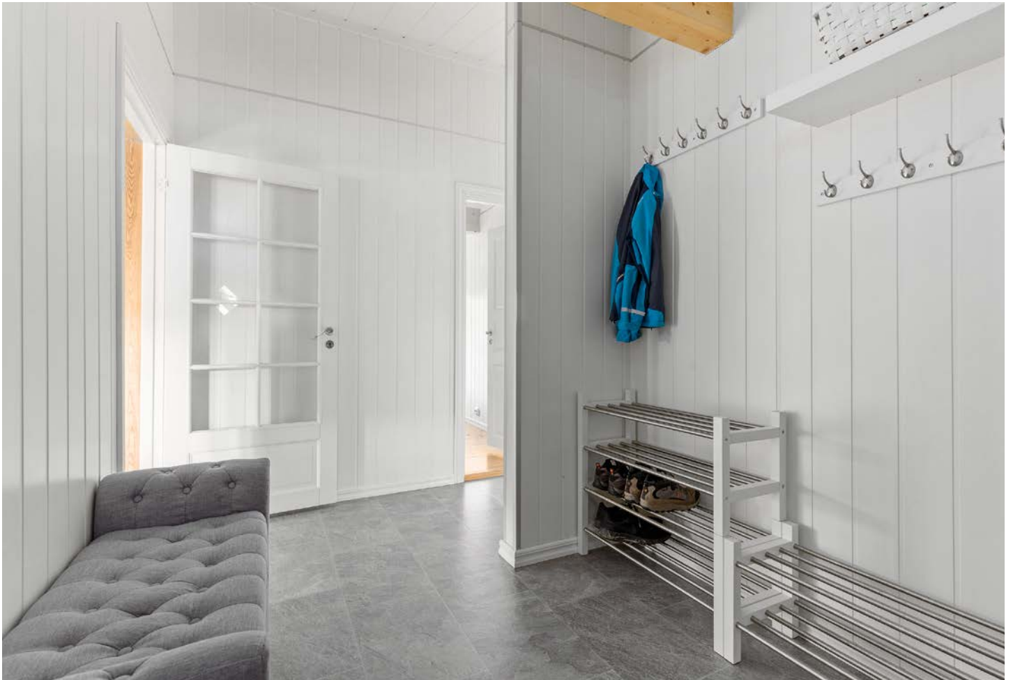
Lys og fin gang med varmekabler i gulv
