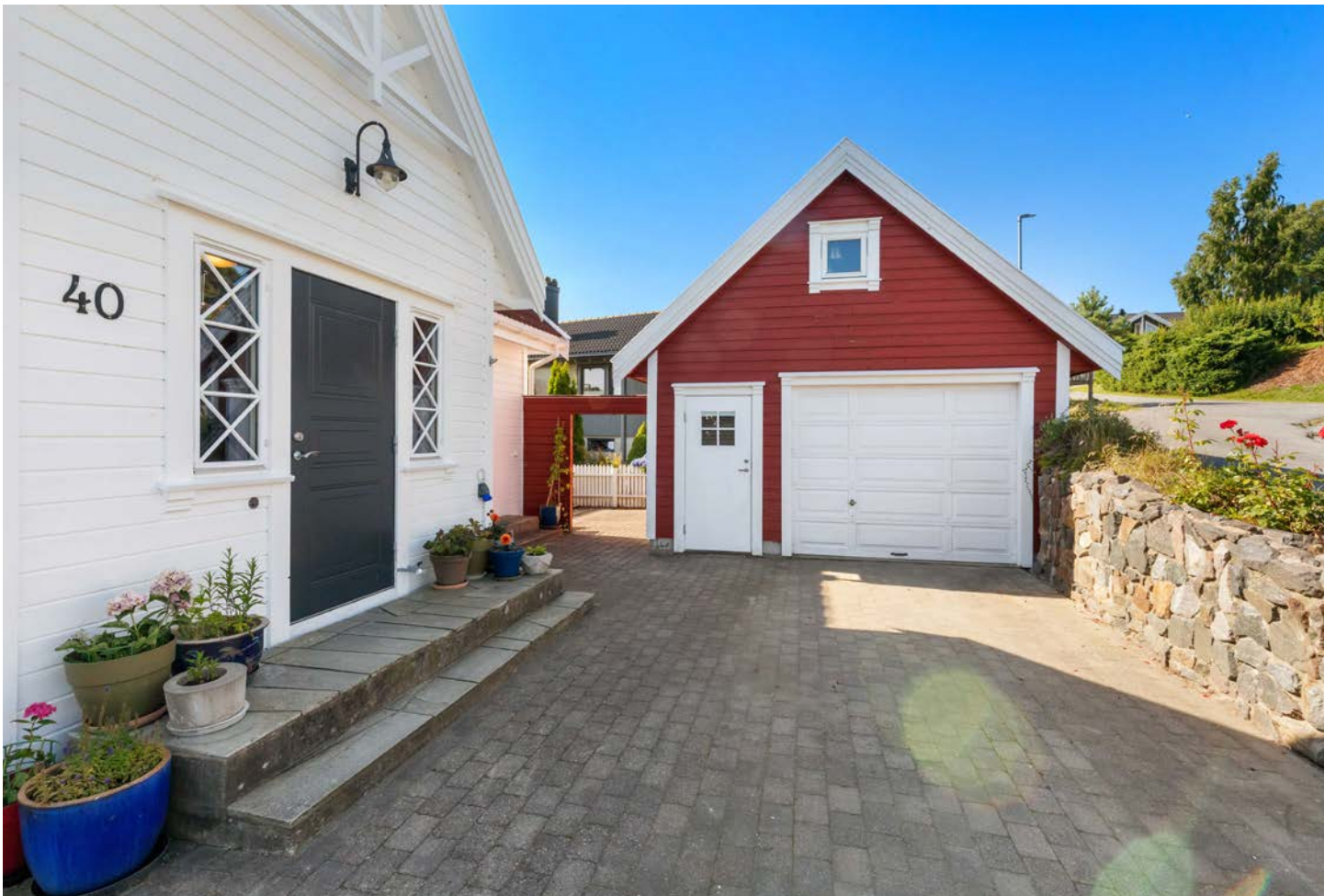
Garasje og biloppstillingsplass
