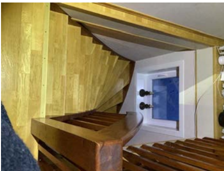
Trapp mangler håndløper å vegghøyde mellom trinn
