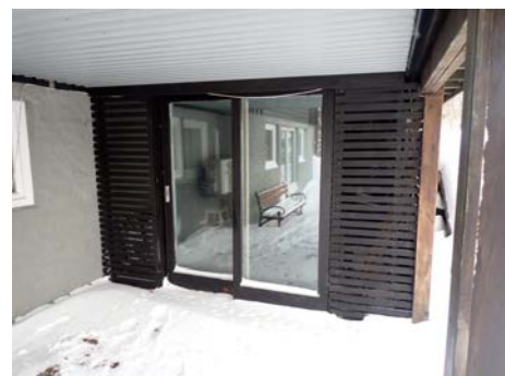
Skyvedør under terrasse
