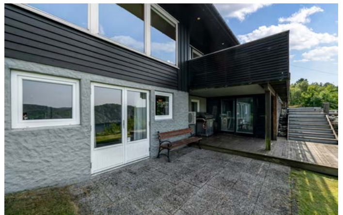
Utgang til plattform fra kjellerstuen. Overbygd og avstengt del
