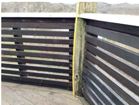
Lav rekkverkshøyde
