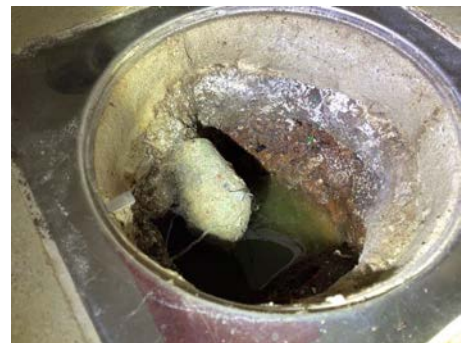
Eldre støpejernsluk uten synlig membran
