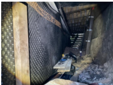
Synlig grunnmursplast på bakvegg mot fjell
