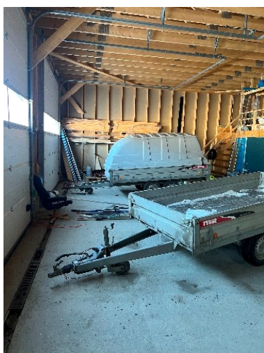
Innvendig i bygg.
