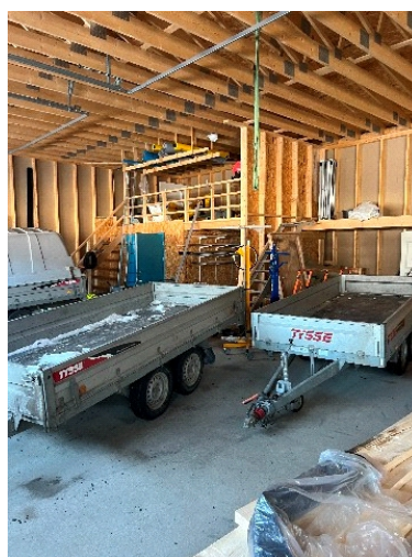
Innvendig i bygg.
