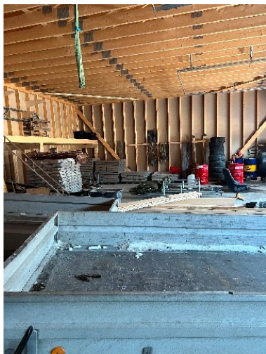
Innvendig i bygg.
