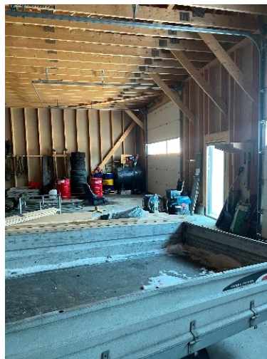
Innvendig i bygg.
