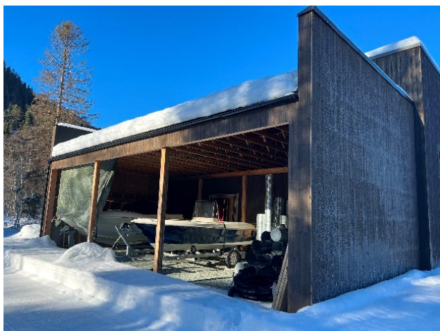
Carport lignende tilbygg mot sør.
